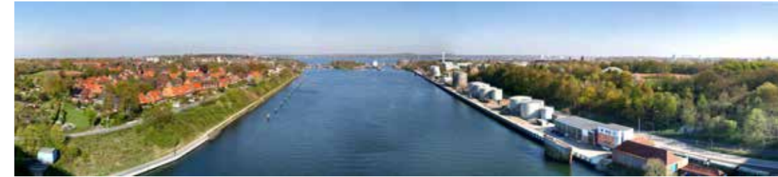
Abb. 1 Nord-Ostseekanal bei Kiel-Holtenau
